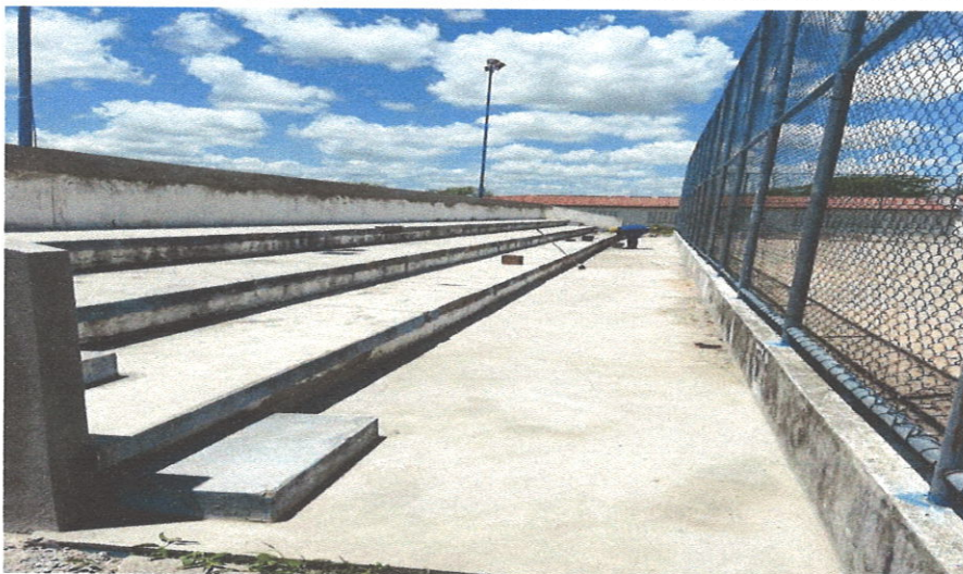
CONCRETAGEM DO PASSEIO
