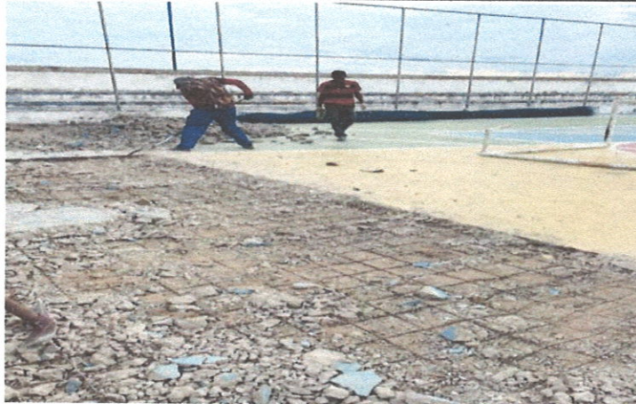
DEMOLIÇÃO DO PISO DA QUADRA
