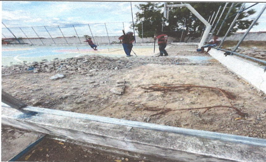
DEMOLIÇÃO DO PISO DA QUADRA
