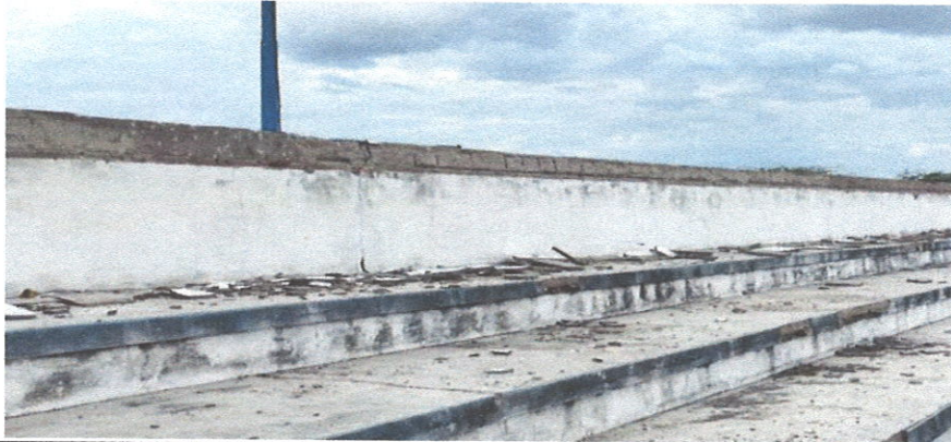
DEMOLIÇÃO DO PISO DA QUADRA
